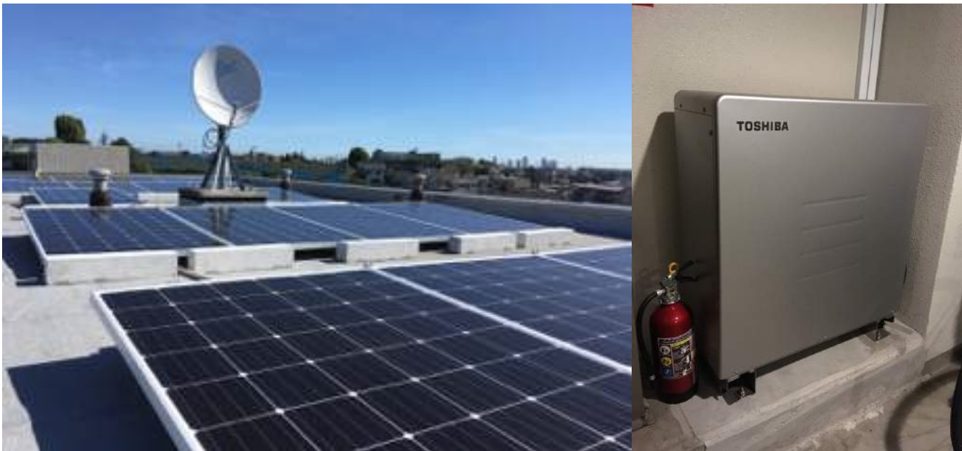
太陽光発電（4kW）と蓄電池（10kWh）を設置したマンション。共用部電気の約50%を供給。
